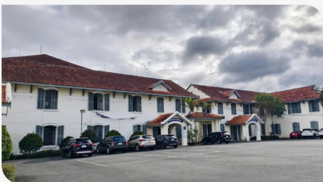
Thi Công Xây Dựng Và Lắp Đặt Thiết Bị Công Trình Cải Tạo, Nâng Cấp Trung Tâm CDC Lâm Đồng
