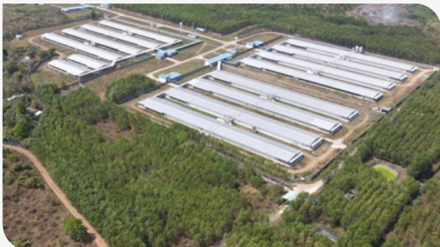
Lắp đặt HTXL nước cấp tại Công ty CP Bel gà
