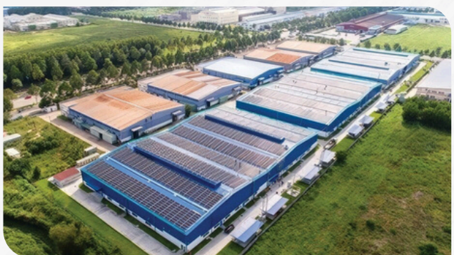
Thi công nhà xưởng cho thuê New CC
